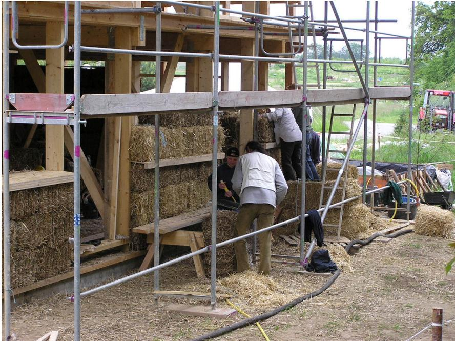
Abb.: Baustelle eines strohgedämmten Hauses, Ökodorf Siebenlinden. Foto: D. Scharmer/FASBA
